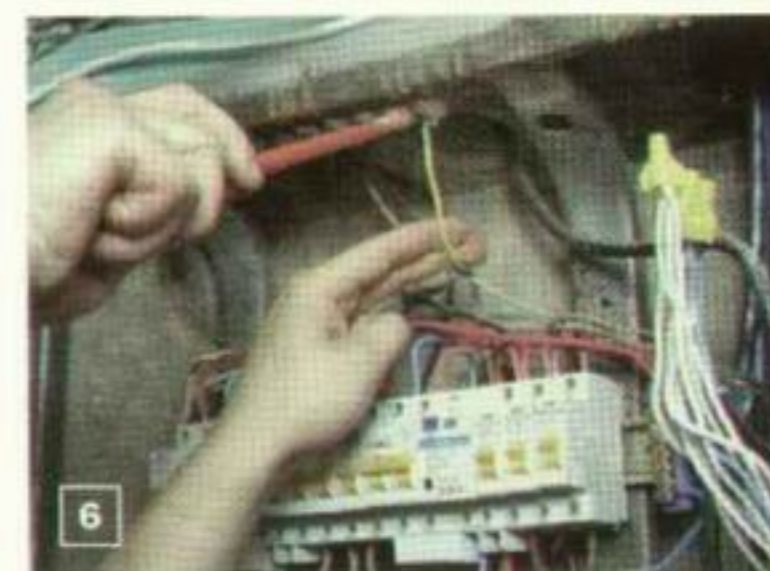
6. Защитное заземление всегда подсоединяют к корпусу электрошита
