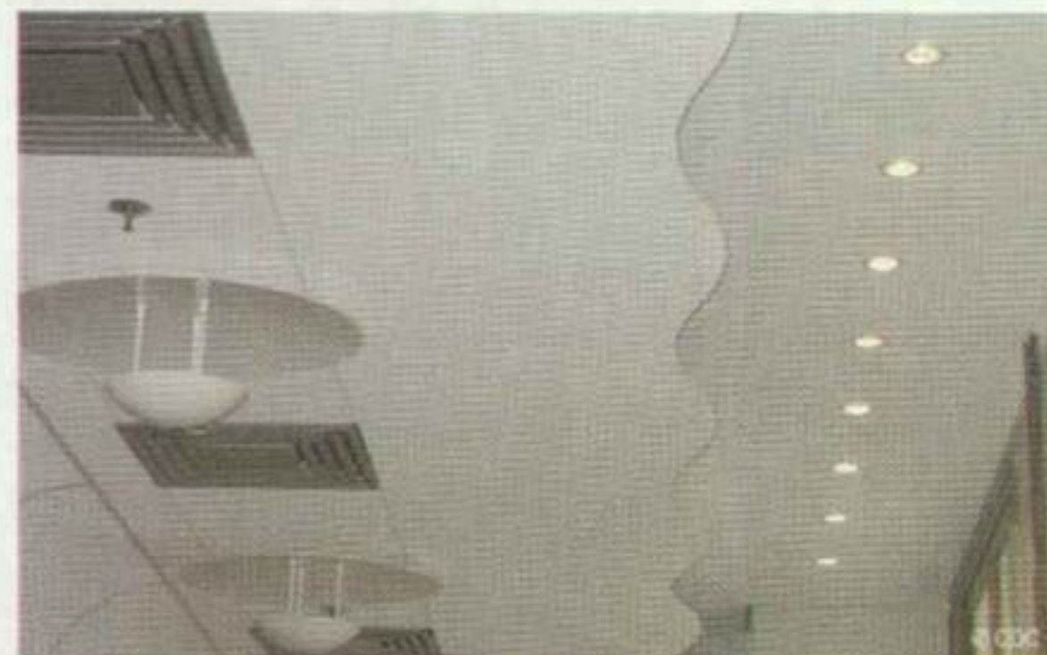
▷ Многоуровневый потолок смонтирован из акустических панелей на основе минерального волокна (Gustafs, Швеция)
