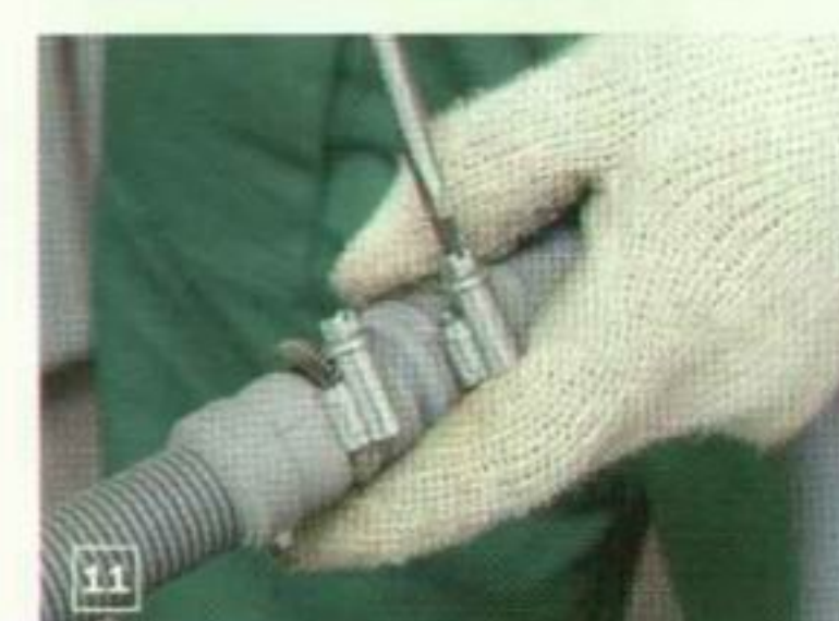
11. Сливной шланг наращивают с помощью соединителя и хомутов
