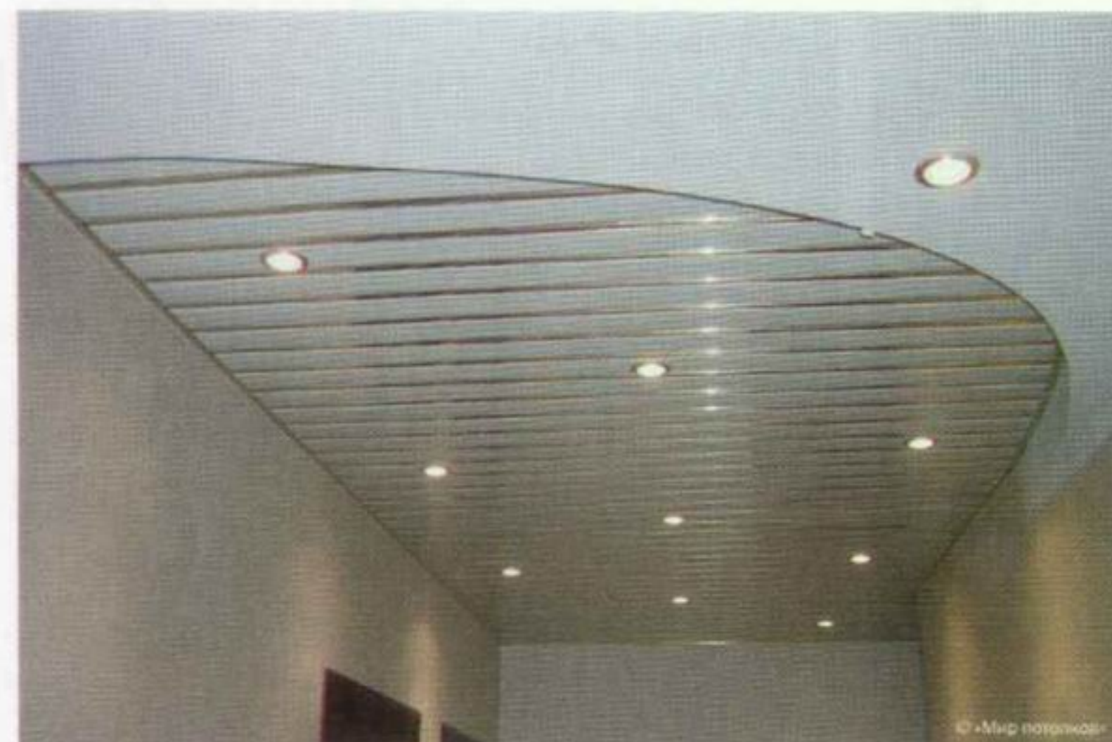
Δ Сочетание реечного и натяжного потолков
