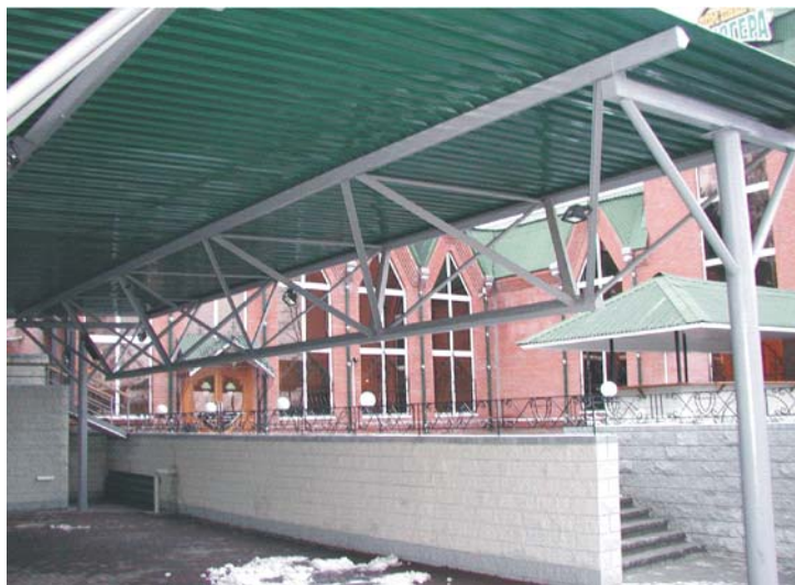
Рис. 2.10. Трехгранные фермы в покрытии (Томск, 2000 г.)
